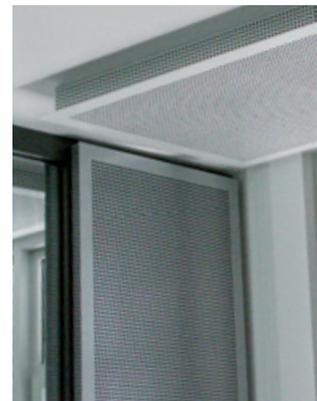
**BKA** | Einsetzbar als Decken- und Vorwandabsorber oder als Festelement im Glas- Akustik-Schallschirm.
